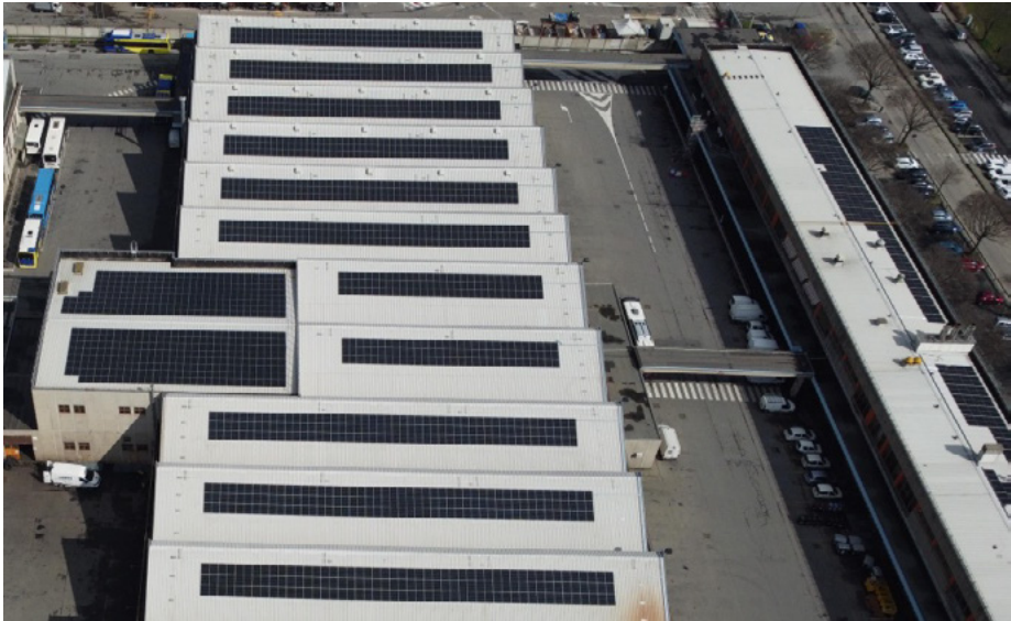
Vista dall'alto dell'impianto fotovoltaico
